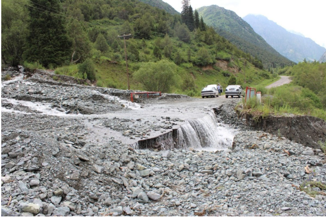
Рис.2.Селевой поток из боковой долины ручья Мурат сай 29 июня 2015г перекрыл полотно автодороги
